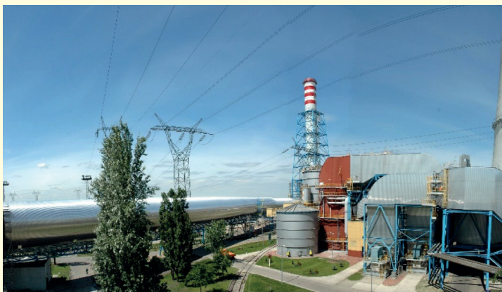
Rys. 10. Instalacja odsiarczania w Elektrowni Kozienice [2]
