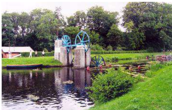
Fot. 4.11. Zabytki hydrotechniczne Kanału Elbląskiego na tle wspaniałego naturalnego środowiska przyrodniczego (1 sierpnia 2004 r.)
