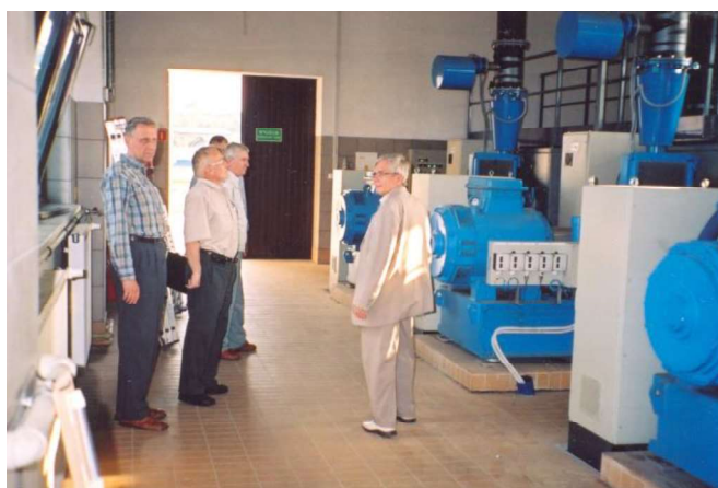
Fot. 5.12. Wycieczka techniczna do Oczyszczalni Ścieków „Kapuściska” (16 czerwca 2005 r.) [3]
